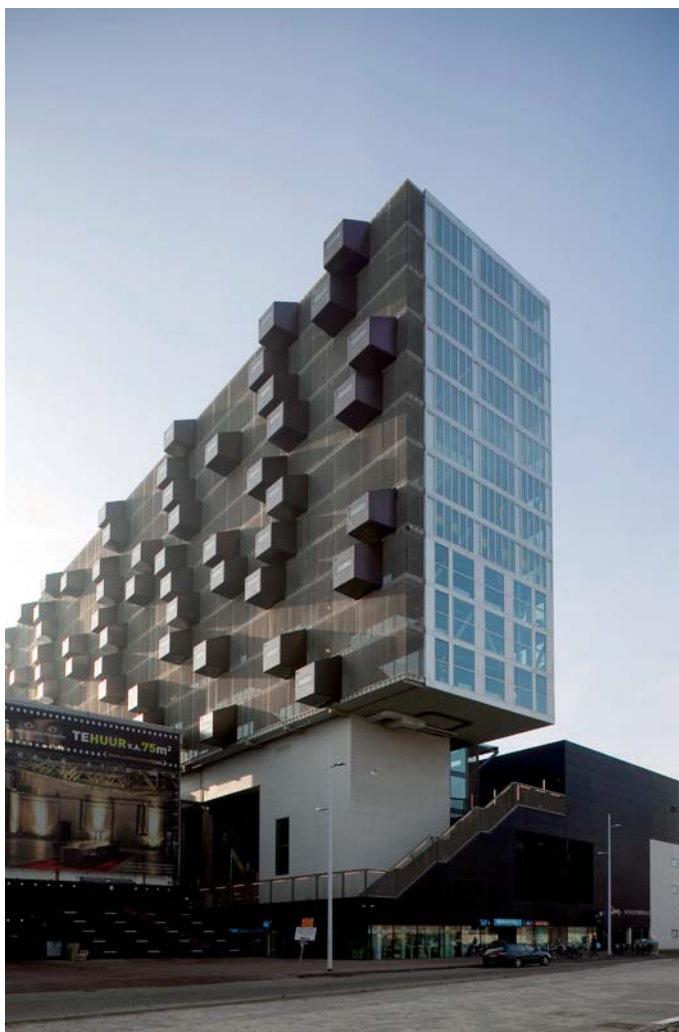
Op de kop van het gebouw is in de plint een supermarkt ondergebracht
