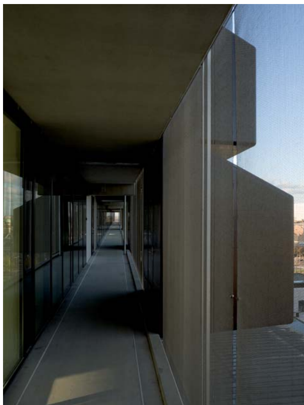
Door de toepassing van stalen doeken transformereren de galerijen tot gangen
